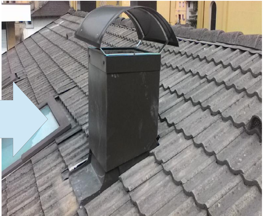
Camino con cappello, rivestimento e conversa in lamiera testa di moro
