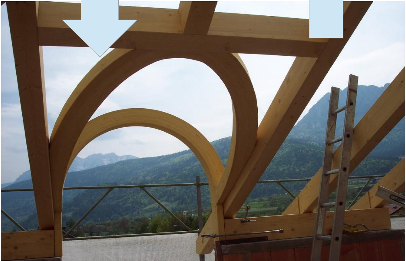
Particolare della lavorazione in testa dei puntoni
