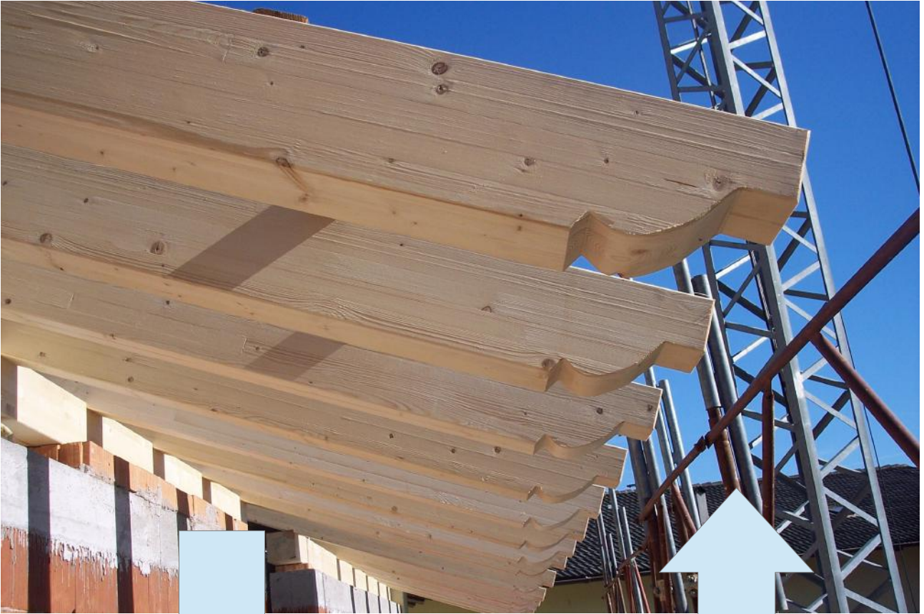
Particolare della lavorazione in testa dei puntoni
